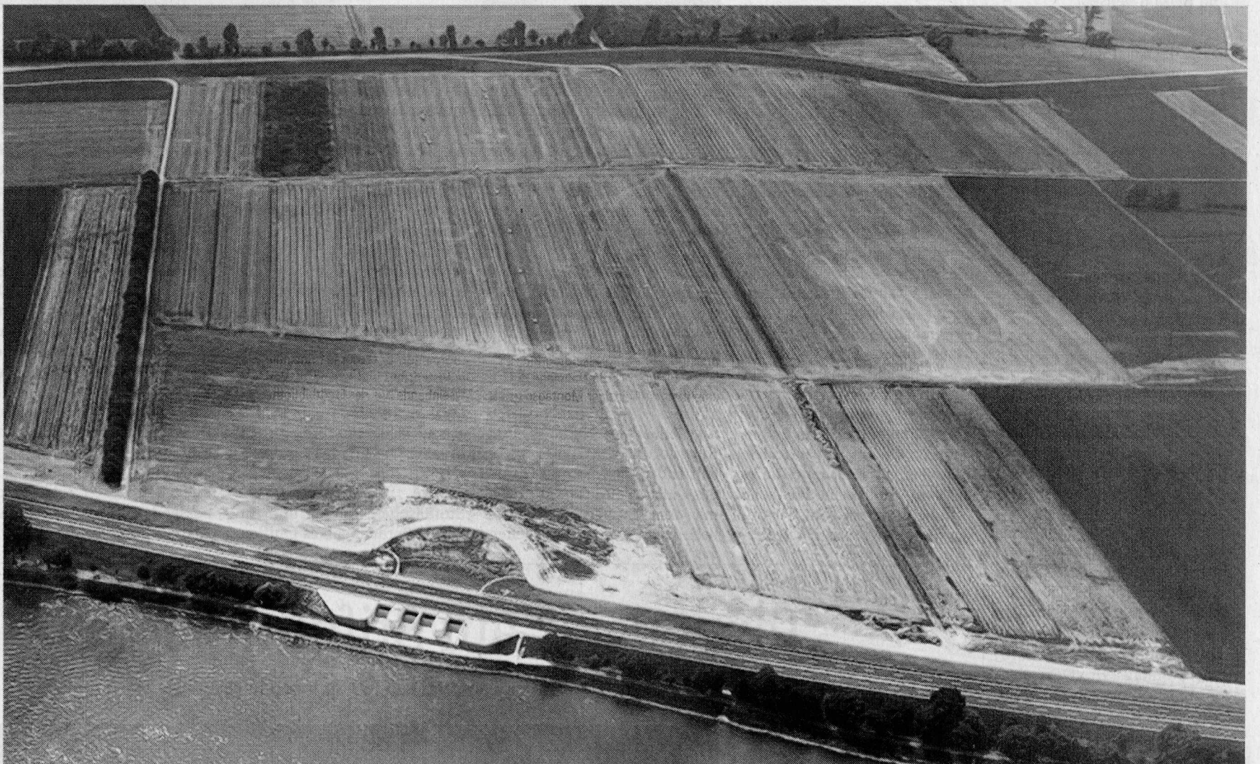
Die Hochwasserrückhaltung Bodenheim/Laubenheim umfasst eine Fläche von 191 Hektar. Im Hintergrund ist der neue Polderdeich zu sehen, vorne dient die B9 am Rhein als Straßendamm. Gut zu erkennen ist das Ein- und Auslassbauwerk unter der Fahrbahn.
